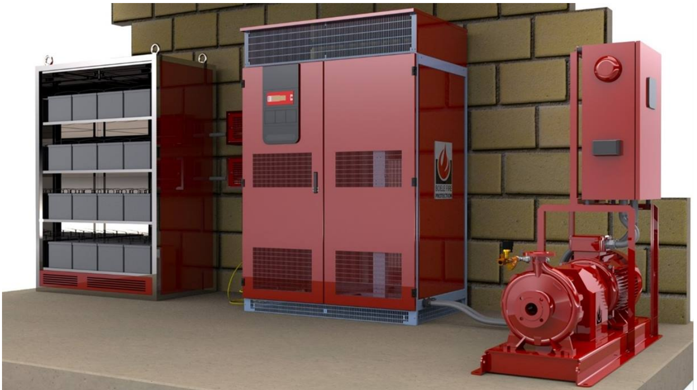
Illustratie van de BPS bestaande uit een accukast (links), een omvormer (midden) voor het voeden van de sprinklerpomp (rechts)
