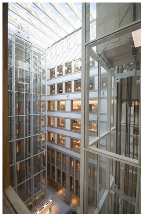
Het Radboudumc in Nijmegen, een smart building gerealiseerd door o.a. Unica vanuit consortium FourCare oplevering (oplevering april 2022).
